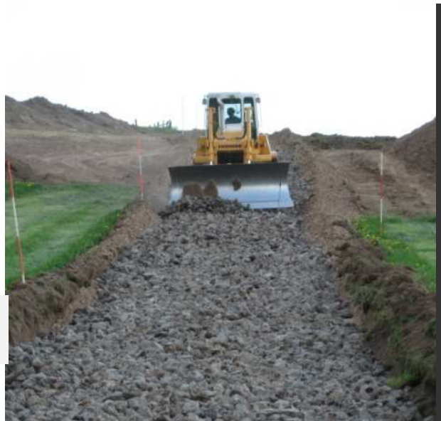
zusätzlich zur Tragschicht 25 cm unsortiertes Gestein erforderlich , erst danach abwalzen
