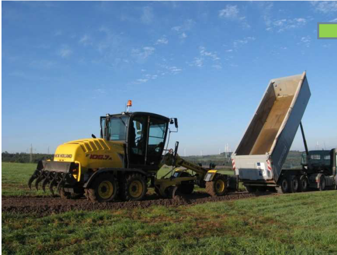
Schüttung der Tragschicht
