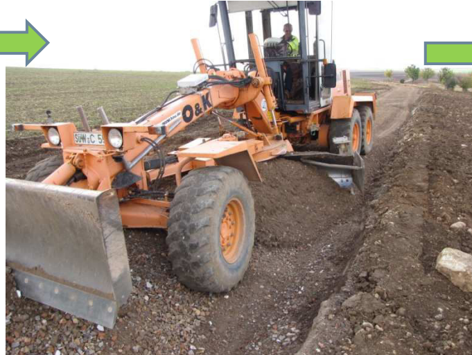
Ausgleichen der Tragschicht
